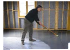
Préparation du sol
